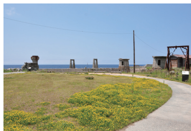
旧佐渡鉱山 大間地区大間港広場 http://www.eau-a.co.jp/works.html#omk
